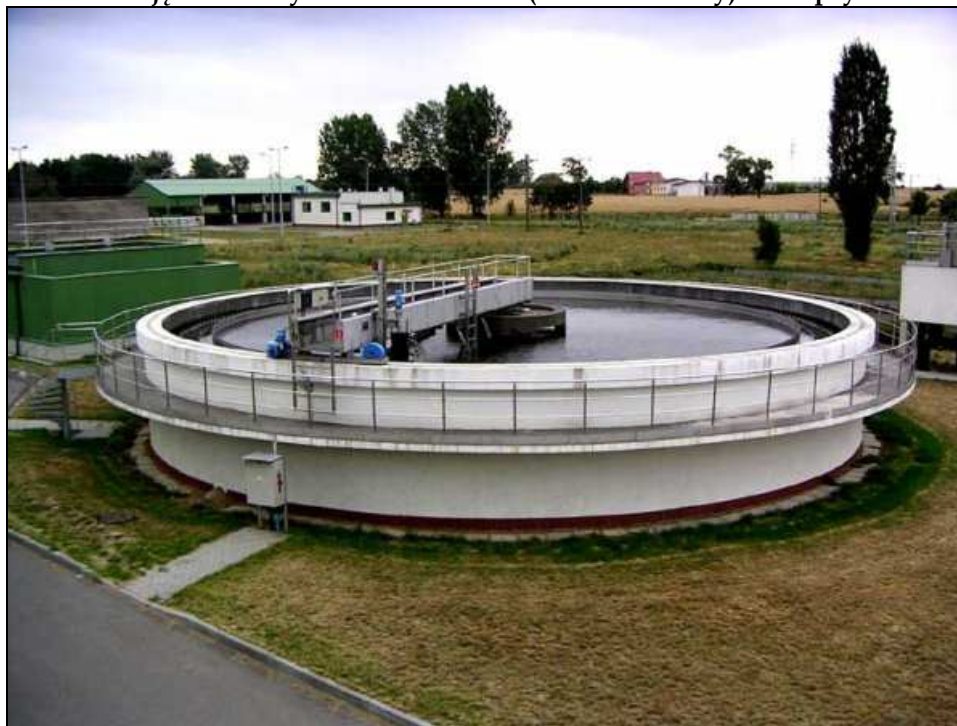
Zdjęcie 2. Oczyszczalnia ścieków (osadnik wtórny) w Słupcy
