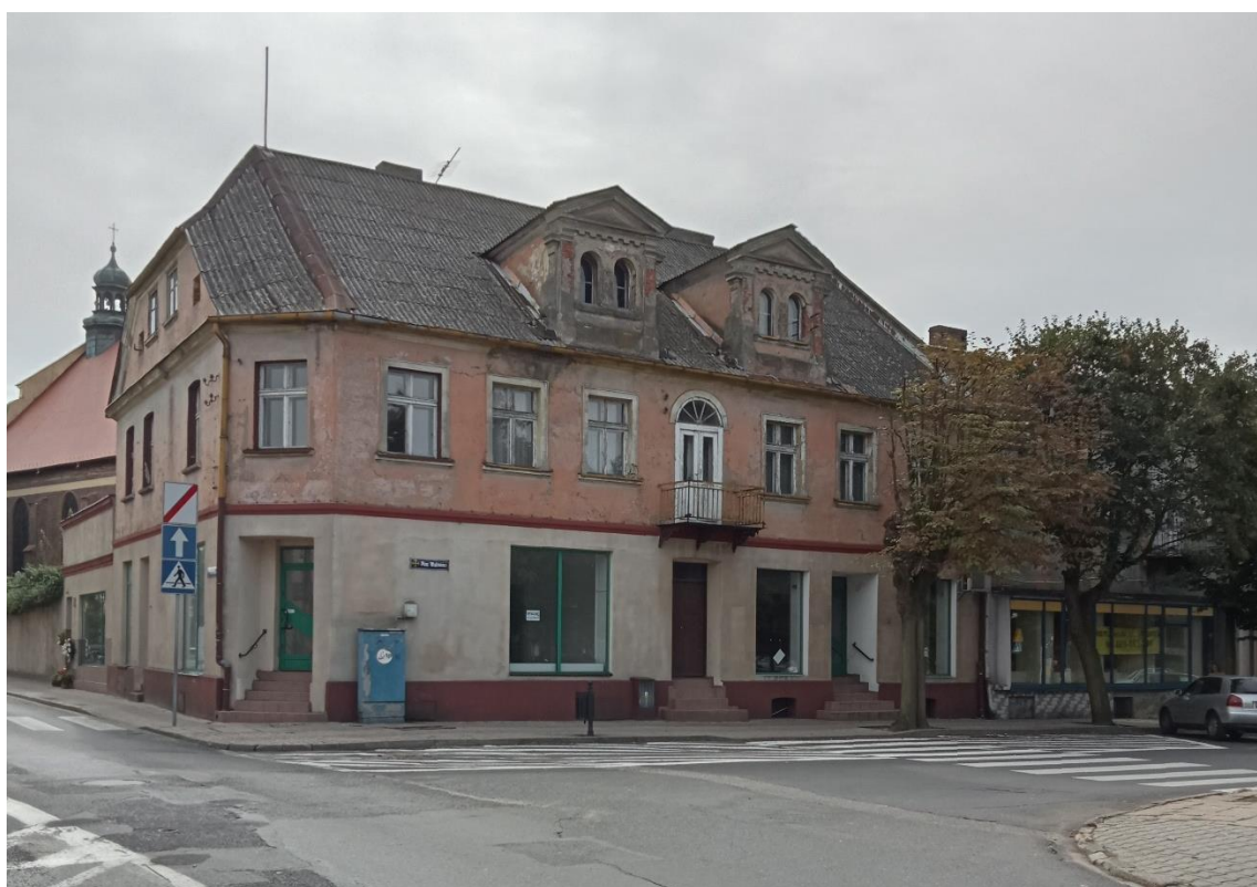
Rycina 17 Kamienica zlokalizowana przy placu Wolności
