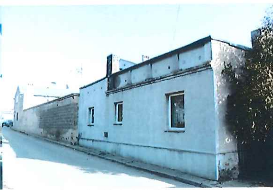
Zdjęcie nr 3. Ubojnia rytualna, ob. budynek mieszkalny z częścią gospodarczą, ul. Bóżnicza 11b
