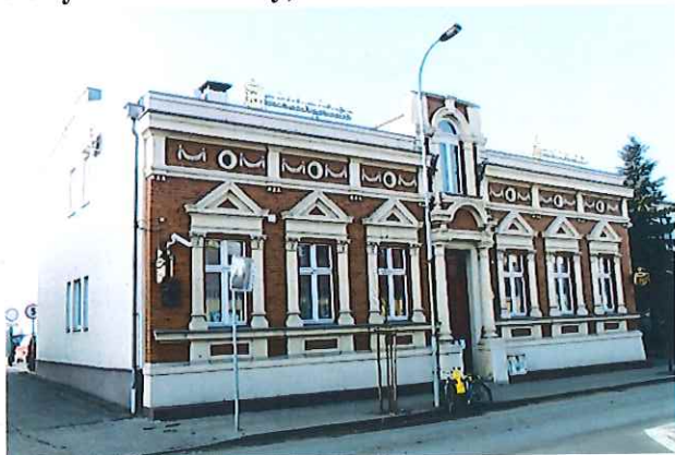
Zdjęcie nr 18. Budynek mieszkalny, ul. Poznańska 15
